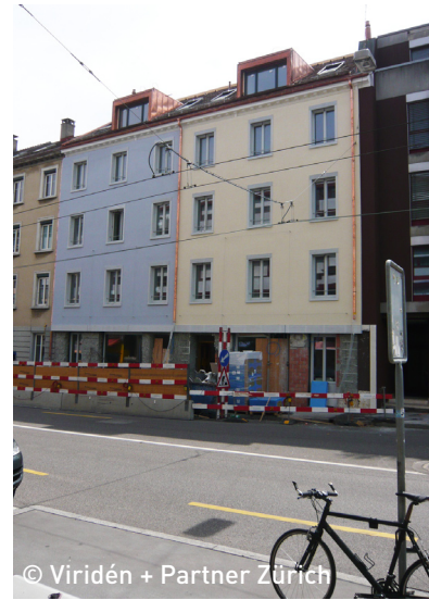
© Viridén + Partner Zürich Strassenfassade
