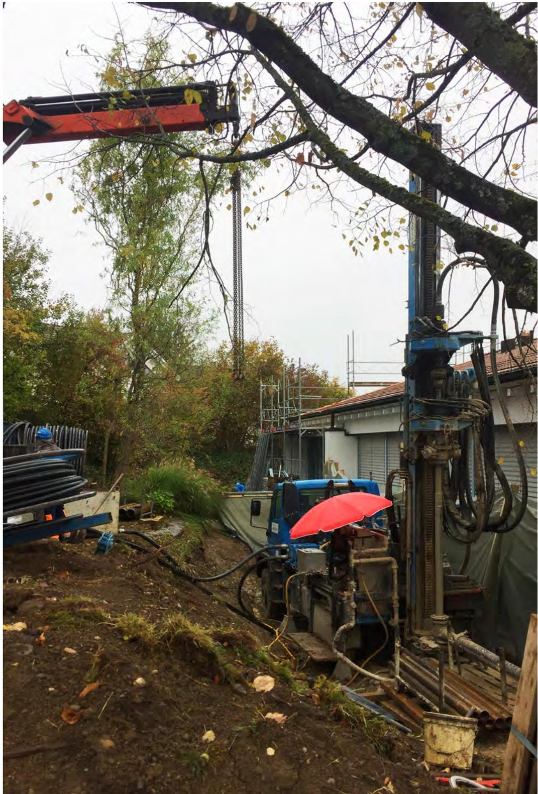
Bohrarbeiten für die Erdsonden
