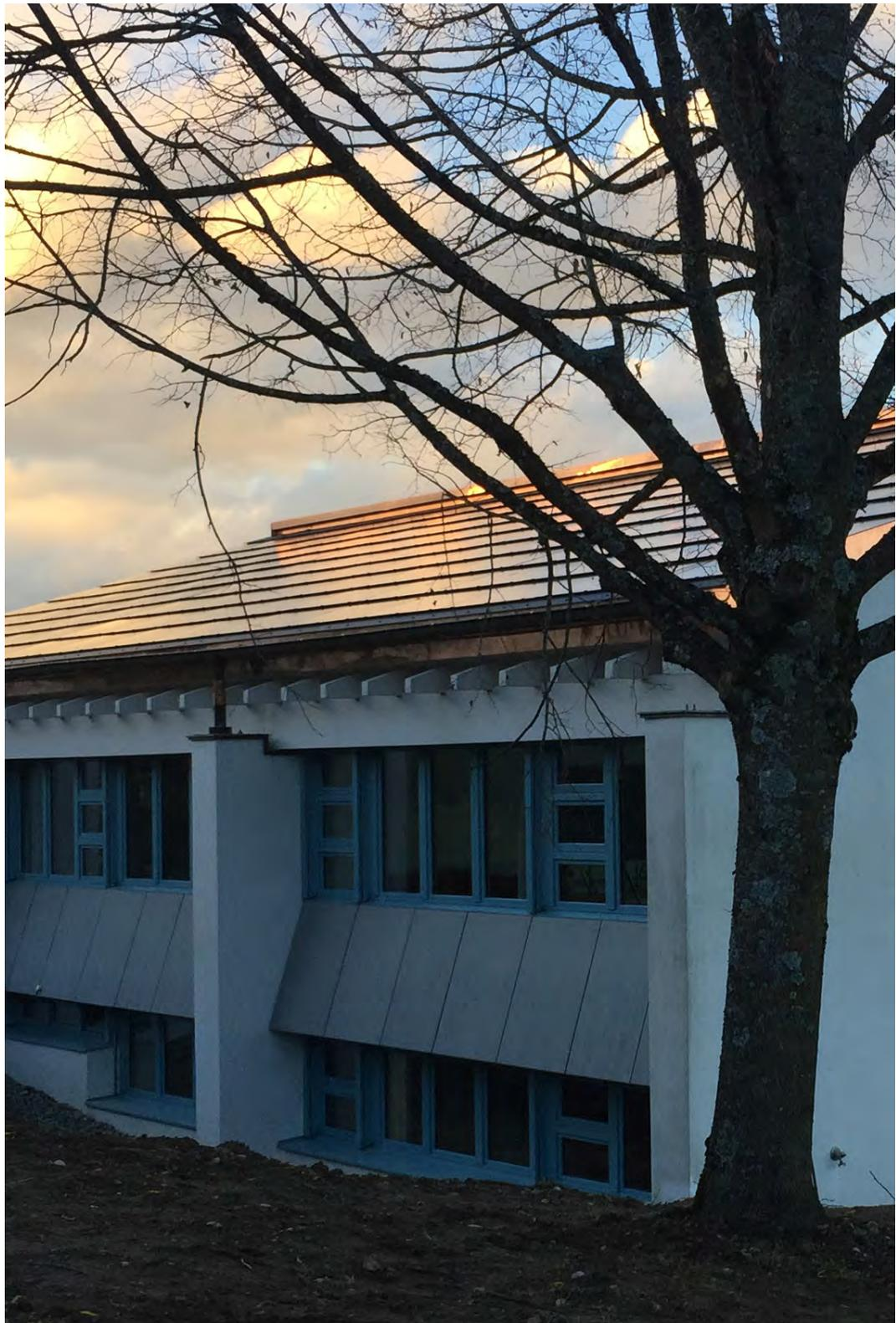
Südanischt: Saniertes Gebäude mit PVT-Dach
