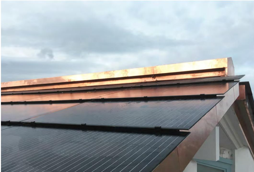
Südwestansicht: Saniertes, nachgedämmtes Dach mit PVT-Anlage
