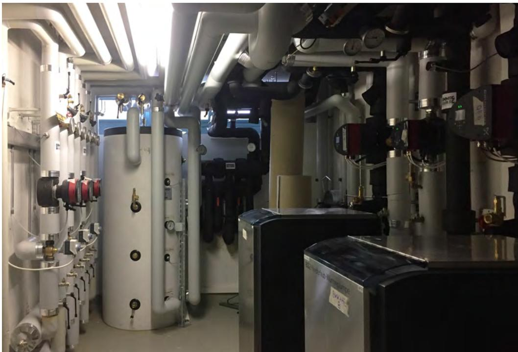
Technikzentrale mit neuen Wärmepumpen, Pufferspeicher und Erdsondeneinführung
