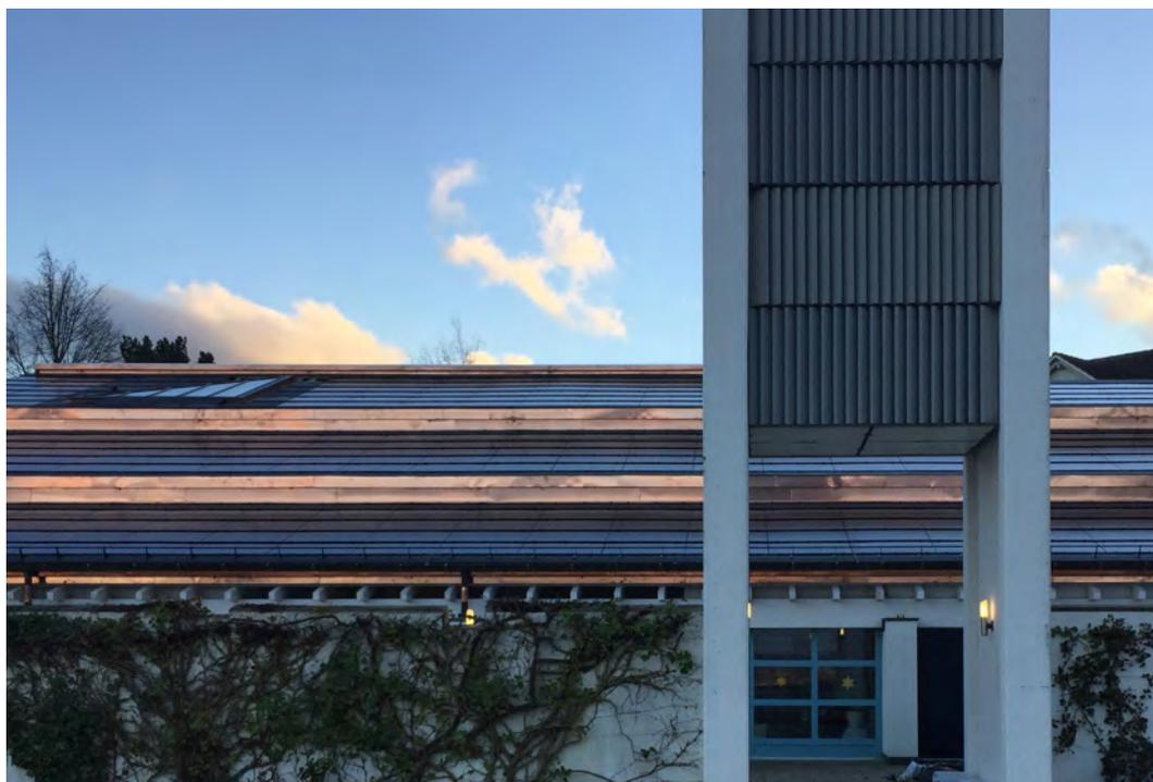
Nordostansicht: Saniertes, nachgedämmtes Dach mit PV-Anlage
