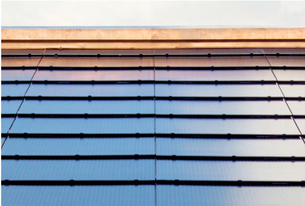
BS2 Solardach mit Photovoltaik und Thermie in Kombination (PVT)
