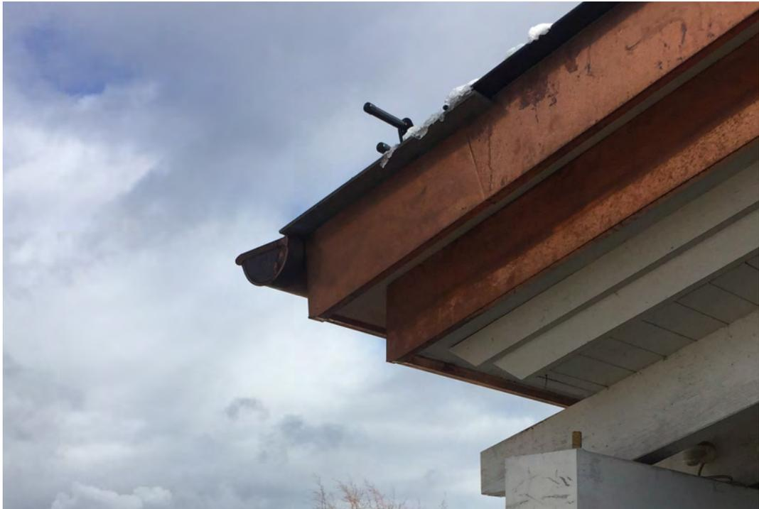
Traufe und Ort mit aufgedoppeltem, wärmedämmtem neuen Dach
