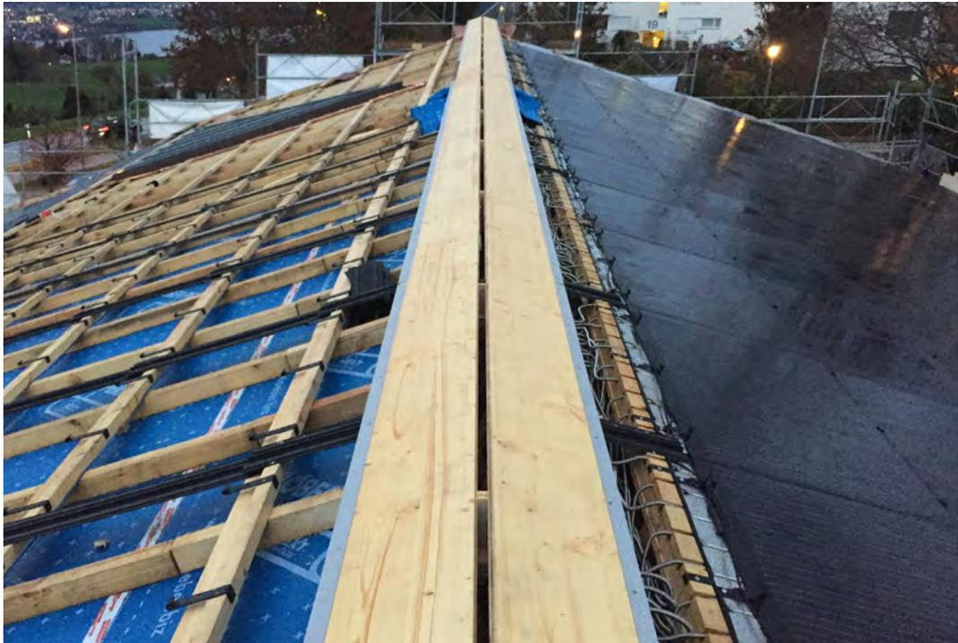
PV-Dach in konventioneller Bauweise links, rechts BS2 PVT-Solardach als Elementbau
