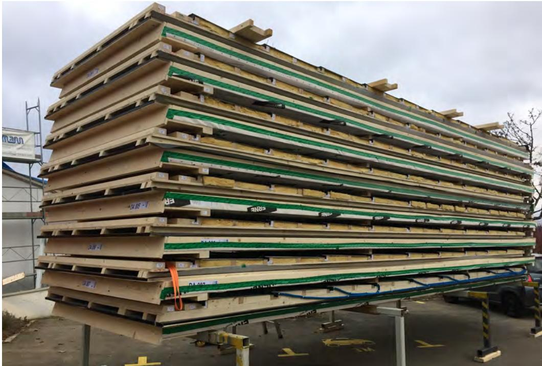
BS2 Solardach-Elemente vor der Montage am Bau
