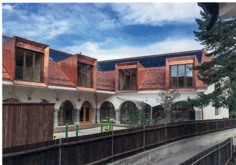
Der umgebaute Nebenbau mit Wohnungen und Doppelkindergarten erzeugt solare Direktgewinne von rund 32 000 kWh bei einer Energiebezugsfläche von 161 m 2 .
