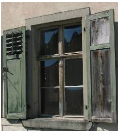
Bild: vor Sanierungsstart, Ansicht außen
