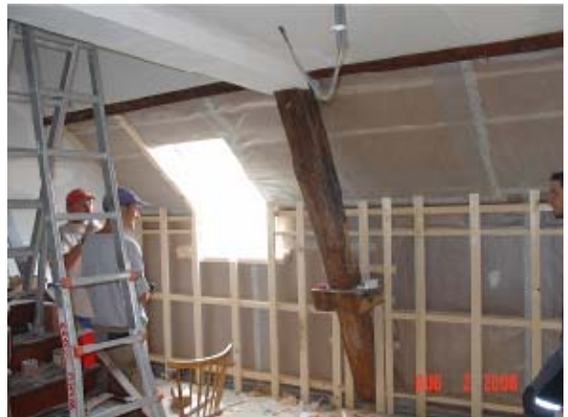
Bild: Holzfaserdämmung im Trockenbau bei Wänden
