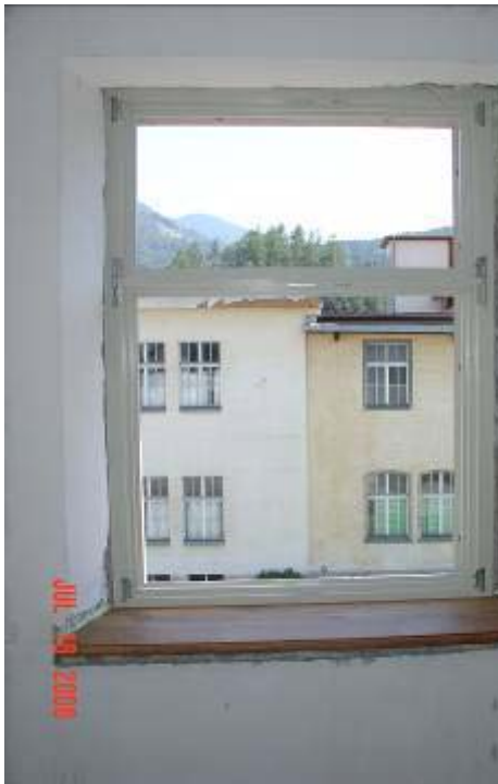
Bild: Fensterbank neu aus altem Holz
