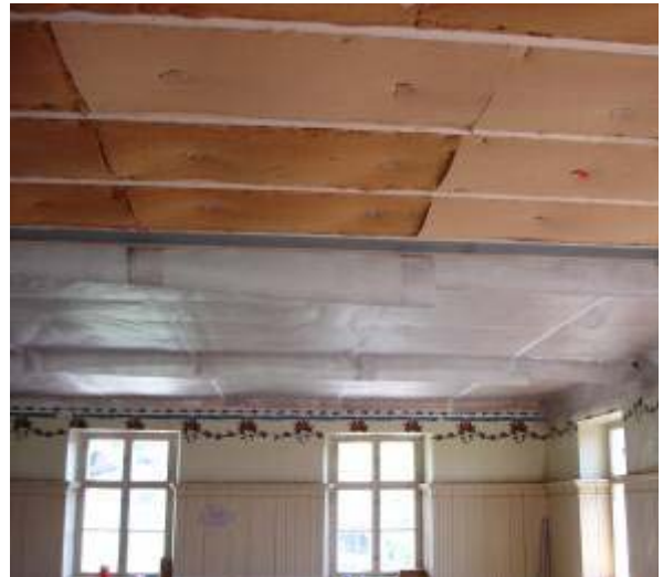
Bild: Dämmung Dach Rosensaal
