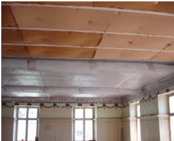
Bild: Holzfaserdämmung im Trockenbau bei Decken
