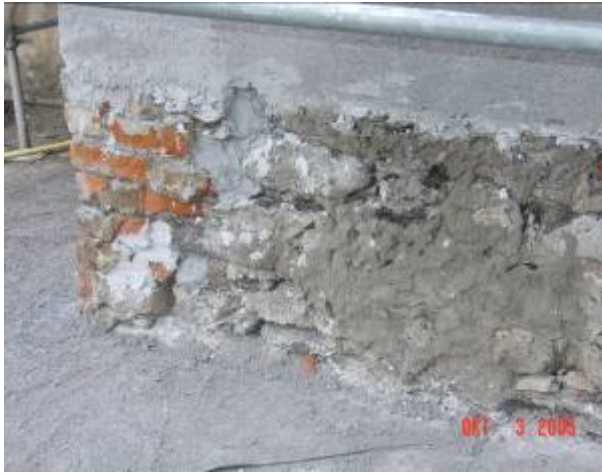
Bild: Sockelputzsanierung
