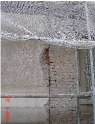
Bild: verschiedene Bauetappen, Spannungsriß
