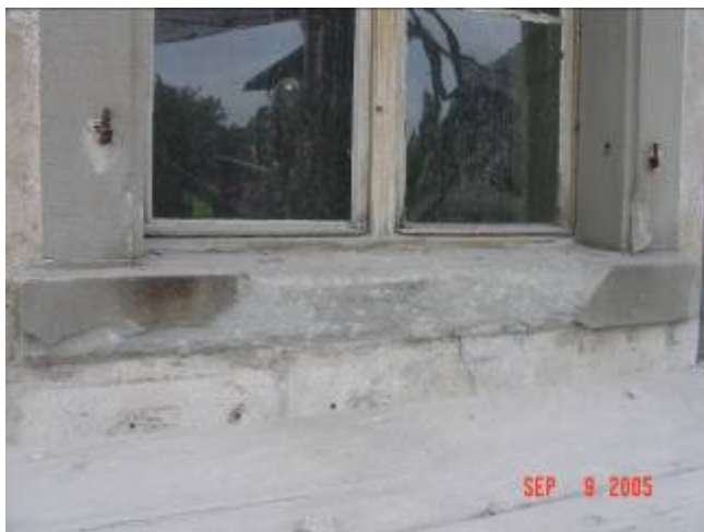
Bild: vor Sanierungsstart der Sandsteineinfassung
