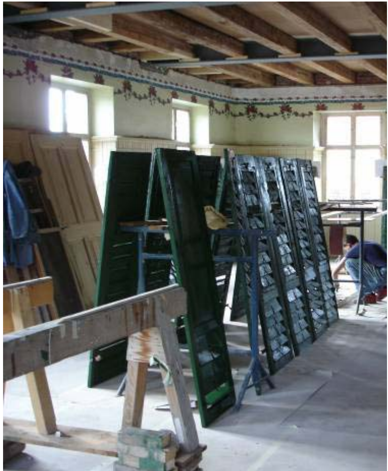
Bild: Fensterläden saniert
