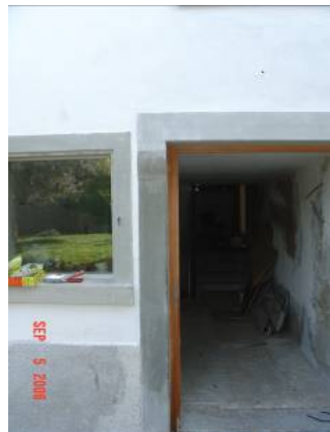
Bild: sanierte Sandsteineinfassung
