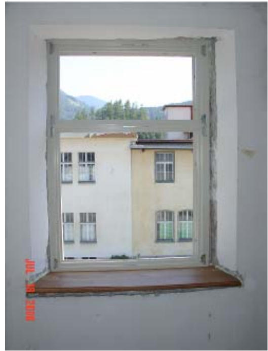
Bild: Fenstereinbau mit Stopfwole
