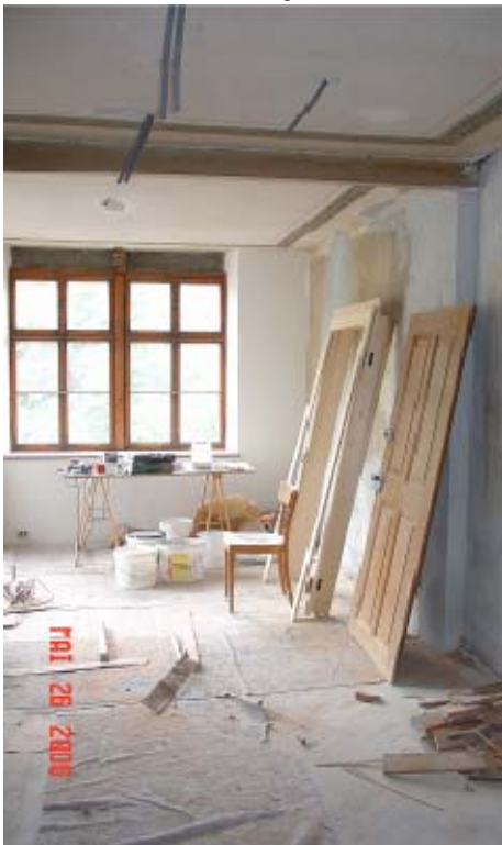
Bild: altes Türblatt mit neuem Stock
