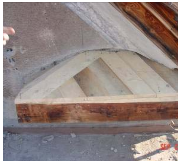
Bild: Dachstuhlansanierung/Fassade (weitere Details siehe auf Oberflächenkatalog)
