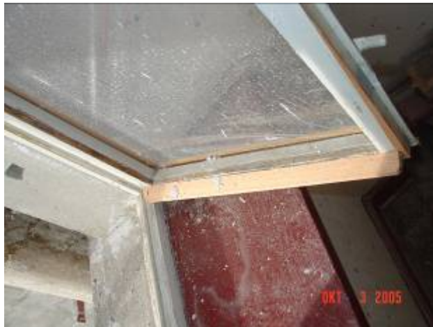
Bild: neue Holz-Wetterschenkel
