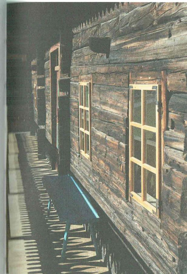
Die Aufdoppelung der Holzaußenwände ermöglichte, dass größere Fenster eingesetzt werden konnten. Dadurch sind Kastenräume zwischen den Fenstern entstanden. Im oberen Teil der ehemaligen Scheune wurde eine Sauna mit angrenzendem Frischluftraum eingerichtet.
