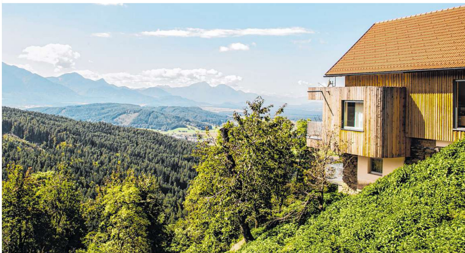
„Haus an der Kante“: Im Kärntner Bleiburg wurden auf den alten Steinmauern eines Stalls moderne Ferienlofts errichtet
