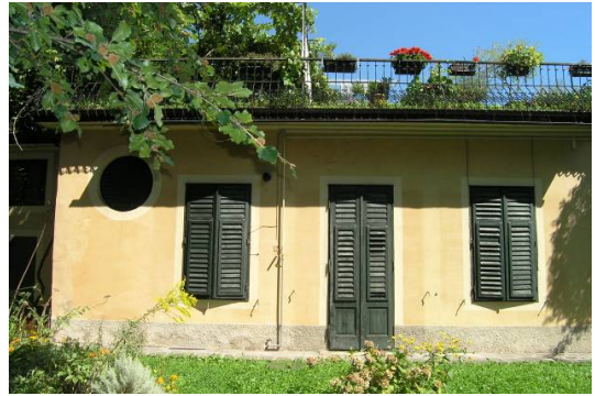
Abbildung 2: Zustand vor Sanierung
