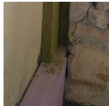
Abbildung 5: thermisch getrennte Innenwand
