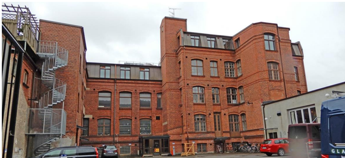
Gårdsfasaderna i fabriken västra del. Gårdens ursprungliga, tidigare fristående byggnad för tvättrum/torkrum/pannrum/maskinrum till vänster, ursprunglig fabrik i mitten och tillbyggnad från 1927 till höger.
