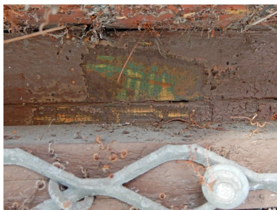
Färgundersökning visar att den ursprungliga fabriken från 1901 hade grönmålade fönster. Här syns skrapning på ursprungligt källarfönster mot gatan med underliggande gröna färglager.
