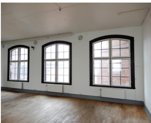
Mindre arbetsal, vy mot gården. Spröjsade, ursprungliga fönster, sekundära innerbågar.
