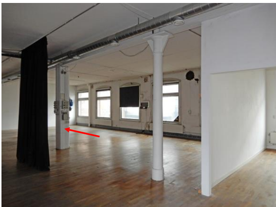
Arbetsal i den äldsta fabriken, vy mot sydöst, mot Friisgatan. Murad/gjuten pelare (pil) är en rest efter ett ursprungligt trapphus.
