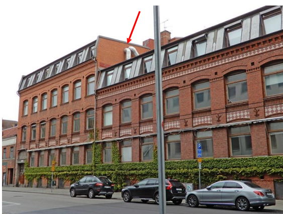
Fabrikens västra del sedd från sydöst. Vid den höga fabriksdelen finns två iögonfallande, kraftiga, galvade/rostfria ventilationsrör.
