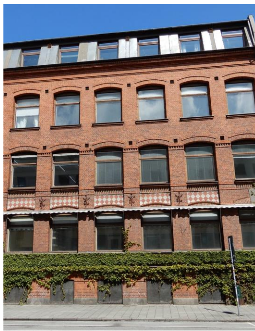
Samma fasadparti idag. Längst ner till höger fanns tidigare en dörr till kontoren.
