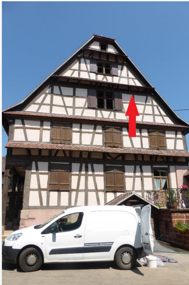
Figure 19 : Sortie des VMC simple flux de l'étage (source : CREBA)
