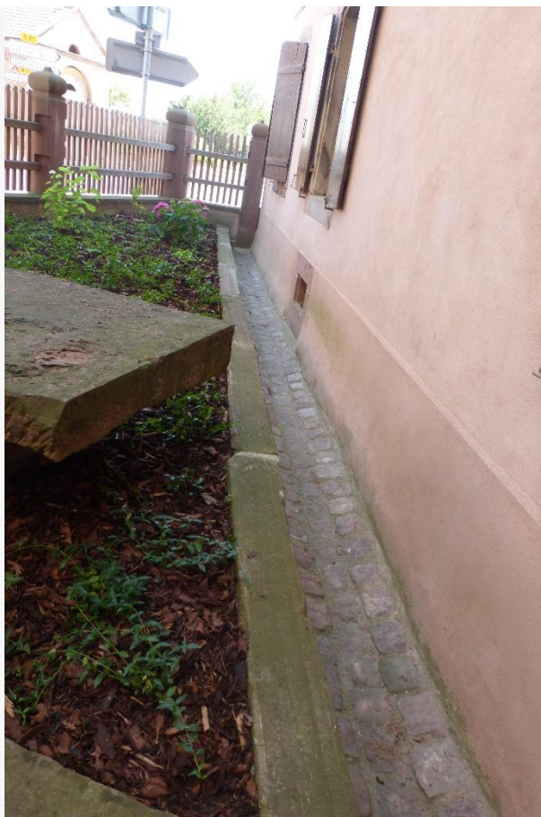
Figure 9 : Petit caniveau à la jonction entre le jardinet et le pignon nord-ouest (source : CREBA)
