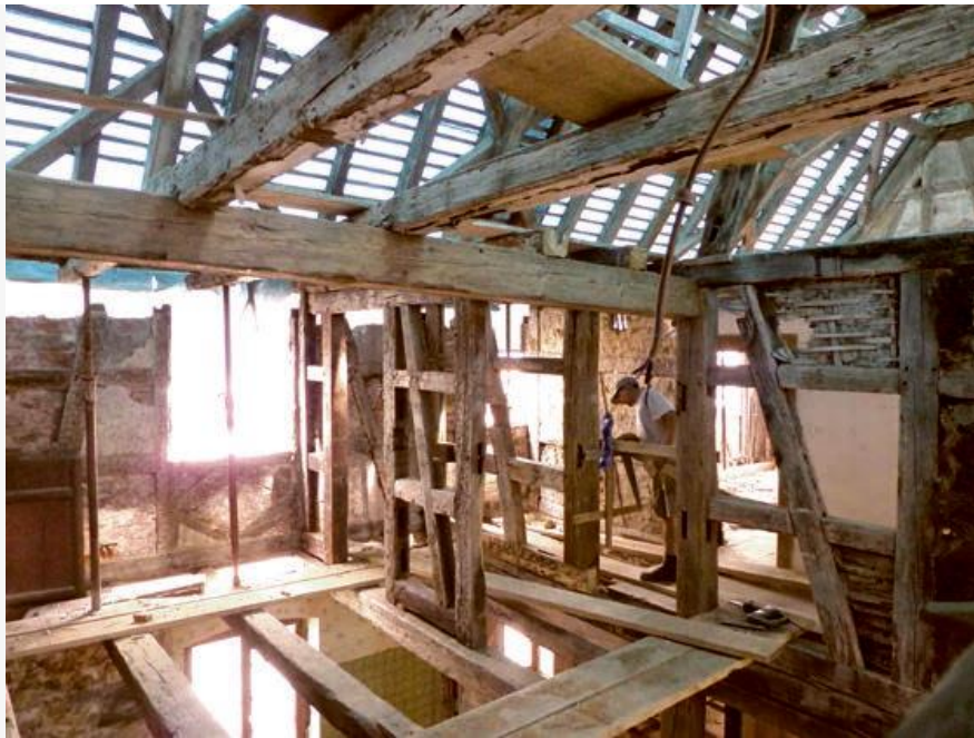
Figure 20 : Le plancher du premier étage a été déposé pour permettre une projection continue du béton de chanvre entre les étages.
