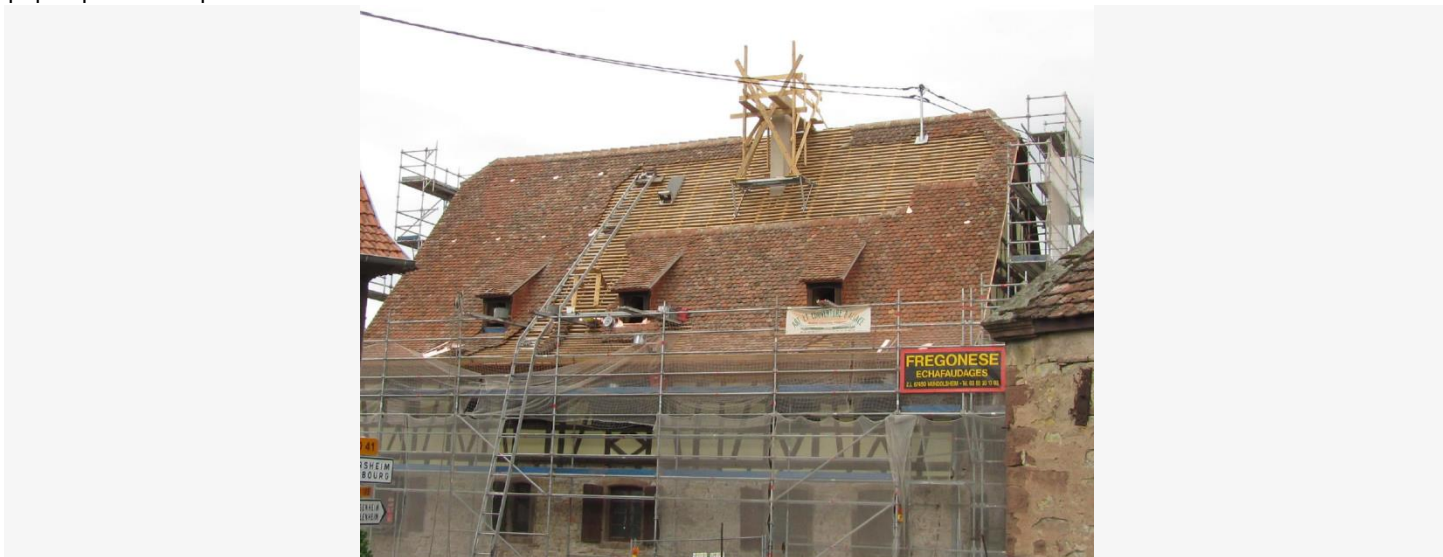
Figure 10 : Partie basse : la peinture plastique et l'enduit au ciment ont été piqués. Partie haute : trois lucarnes ont été créés et de nouvelles tuiles « Biberschwanz » sont venues compléter les anciennes. Des points clairs apparaissent régulièrement à gauche : il s'agit de chatières plates en cuivre.
