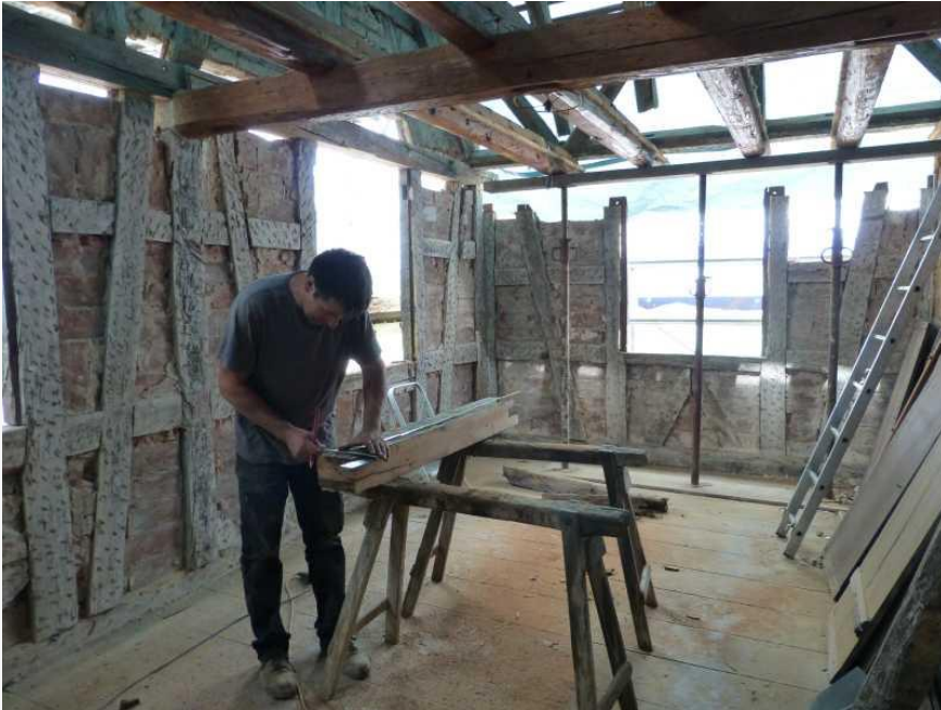
Figure 3 : Réalisation de tenons et mortaises pour le pan de bois
