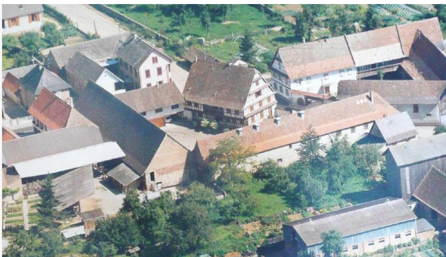
Figure 2 : La maison présente trois dépendances distribuées autour d'une cour intérieure
