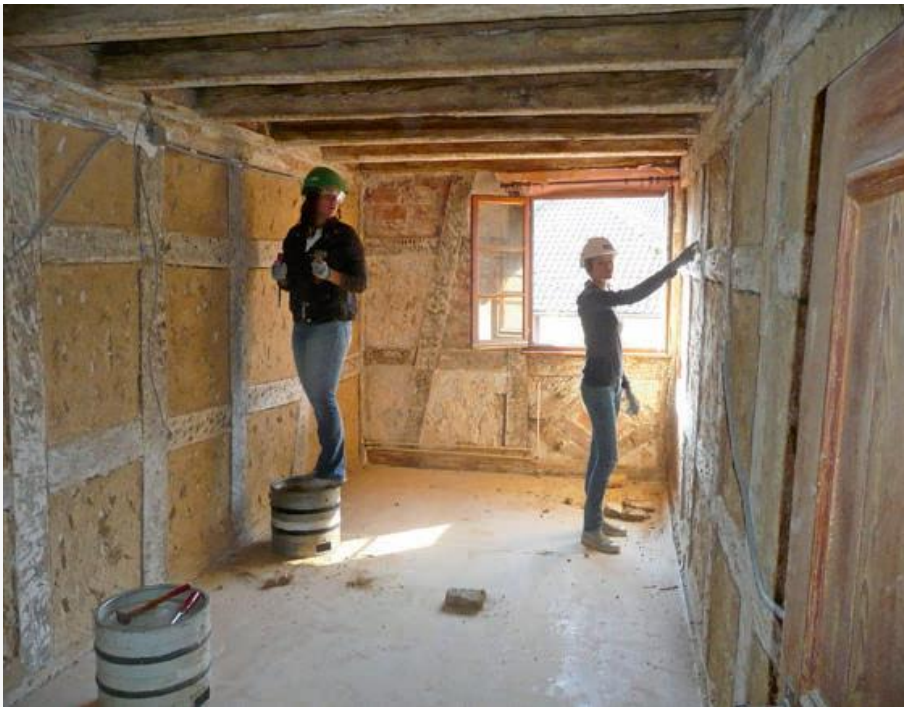
Figure 5 : Décroûtage des murs en pan de bois
