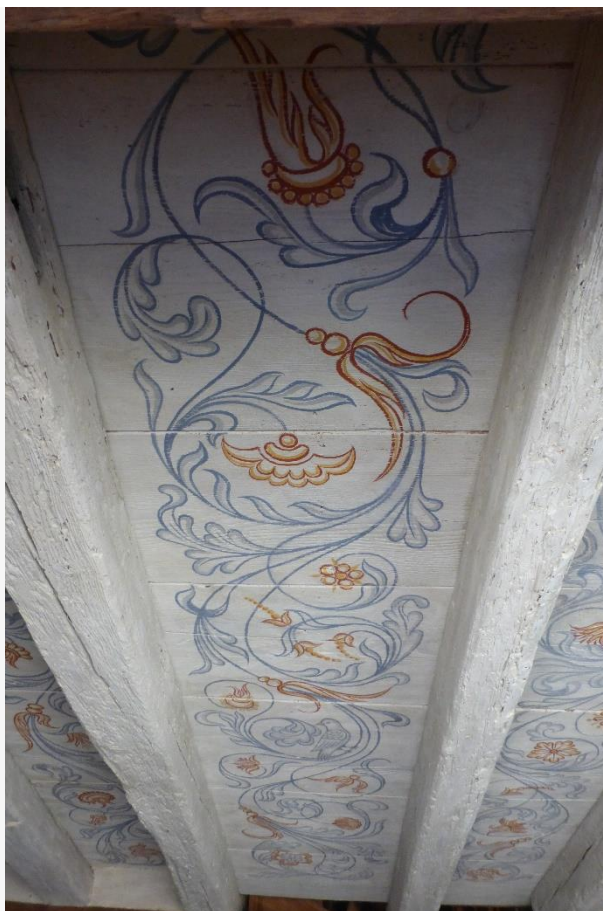
Figure 7 : Plafond peint dans l'entrée de la maison (source : CREBA)
