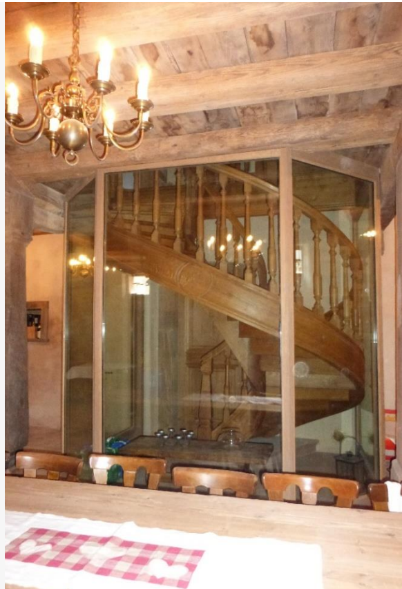
Figure 21 : Baies vitrées séparant la cage d'escalier de la cave (source : CREBA)
