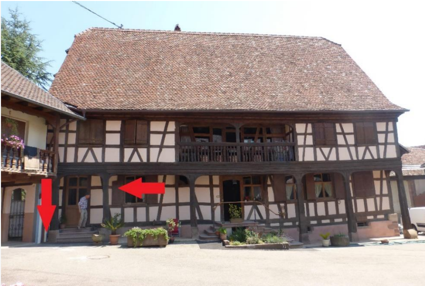
Figure 16 : Le plus à gauche : sortie de la VMC double flux. Derrière le volet : entrée de la VMC double flux. Au milieu : loggia vitrée (source : CREBA)
