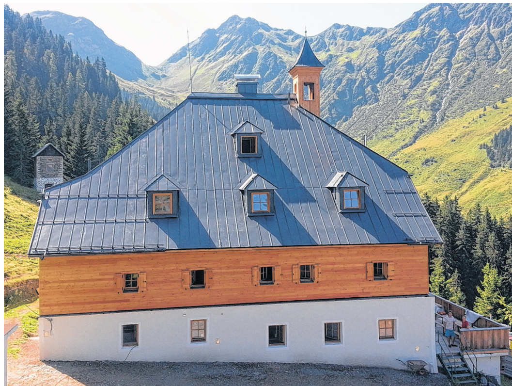
Nach der ökologischen Sanierung erstrahlt die Kelchalm auch äußerlich in neuem Glanz.
