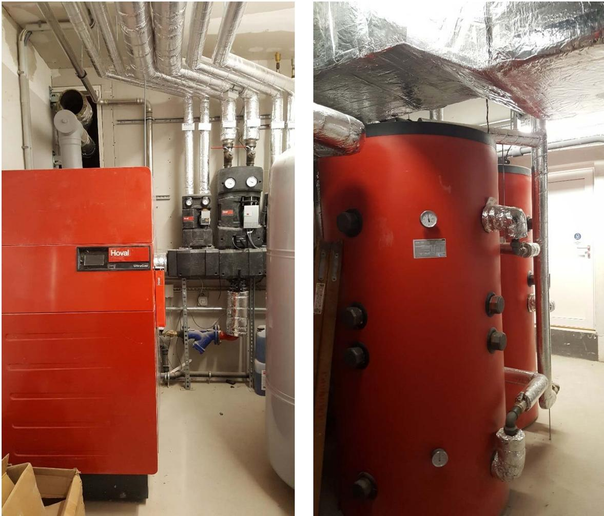
Abbildung 2 Links: Gaskessel, Rechts: Pufferspeicher; Quelle: e7
