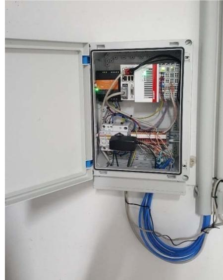
Abbildung 5 Links: Datensammler and GSM- Router an der Wand montiert; Rechts: Innenleben Datensammler, Quelle: e7
